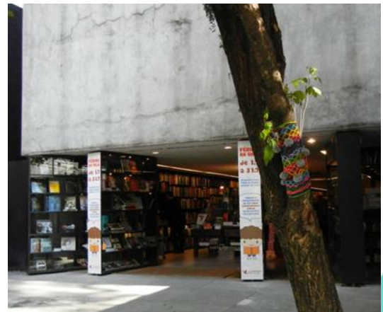
Figura 12: Portas pivotantes como estante na fachada
