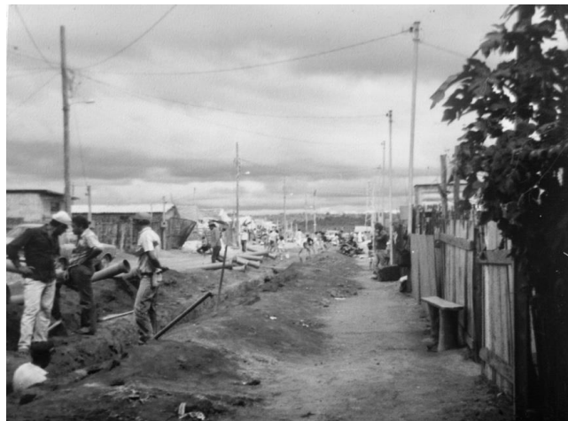
Figura 2 – Registro fotográfico da abertura das ruas para implantação da tubulação.
