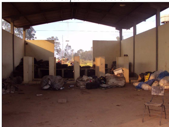
Foto 4: Galpão no Lixão de Cumari
