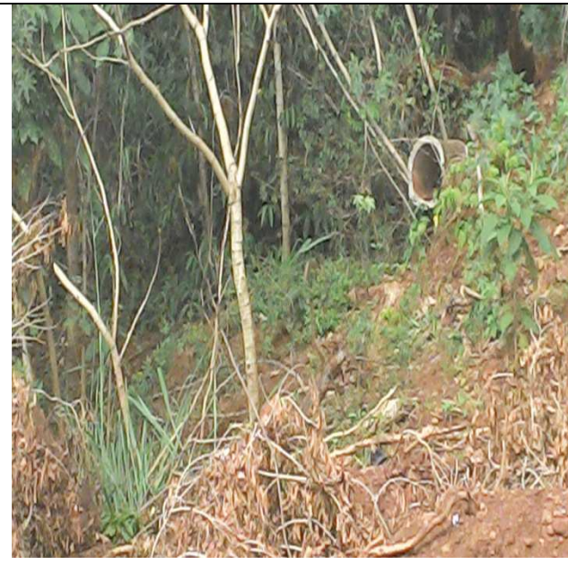
Figura 10 - Tubulação de esgoto presente no segundo ponto, no bairro Parque Bela Vista
