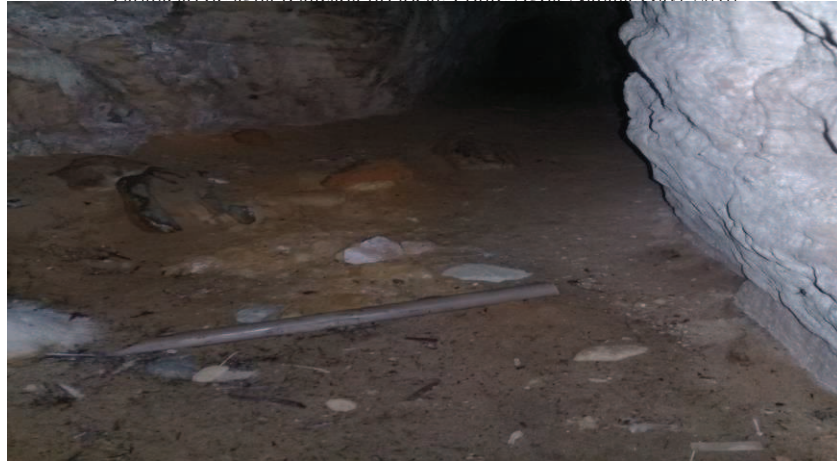
Figura 12 - Segundo salão da caverna do Japoneis, no qual podemos notar restos de materiais de construção usados para a construção da captação de água realizada no local. Fonte: Arda Natalia Davi-2018
