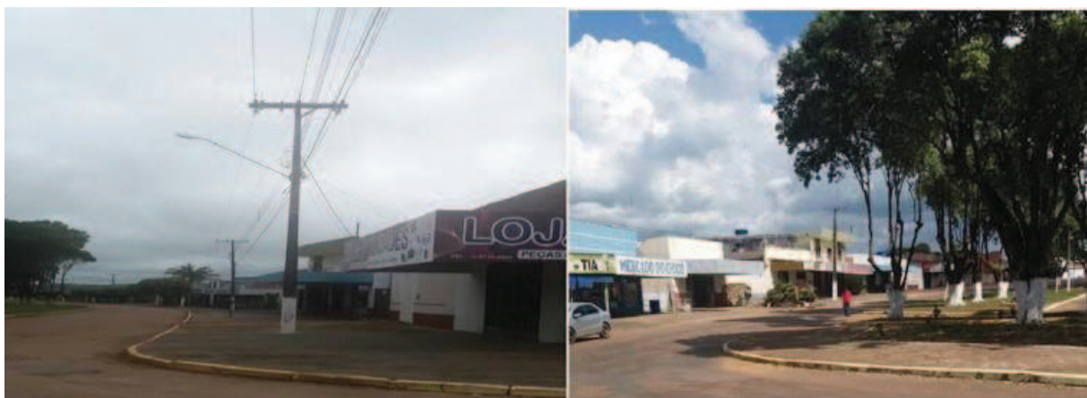
Figura 5- Visão panorâmica da Avenida Ipiranga
