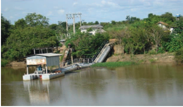
Foto nº 01. Bombas para coletar água para irrigação no Projeto Rio Formoso –TO
