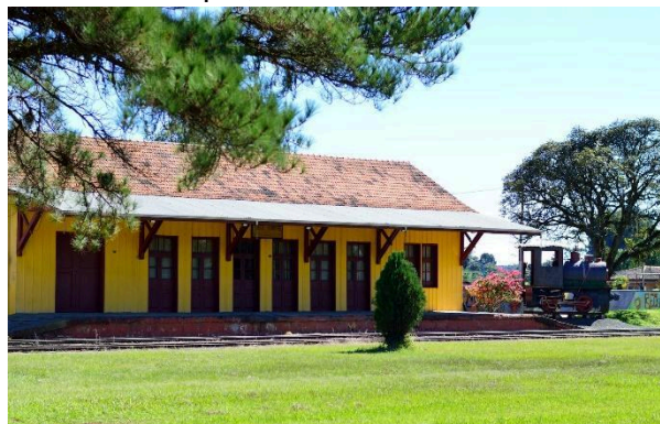
Figura 2: Estação de Três Barras, sede do Museu Municipal, 2026.
