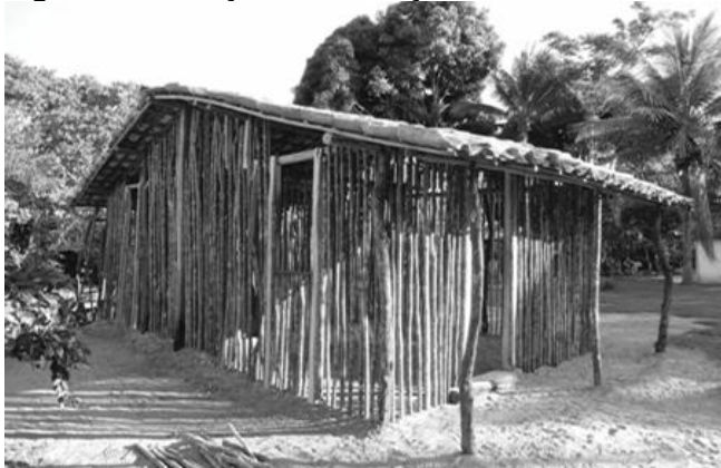
Figura 6. Edificação com vedação em trama de madeira de vedação no quilombo Salamina-Putumuju.
