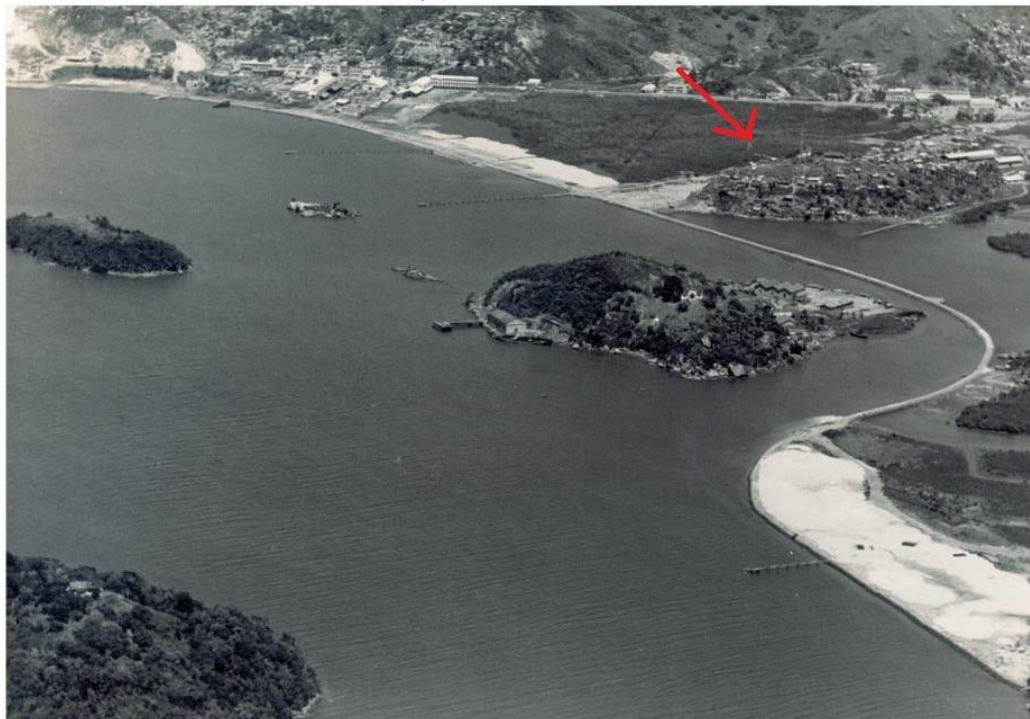
Figura 8. Enrocamento na Baía de Vitória, década de 1950.
