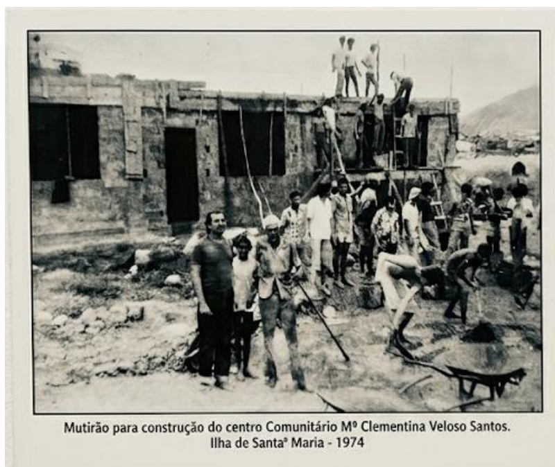
Figura 16. Centro Comunitario da Ilha de Santa Maria - 1974
