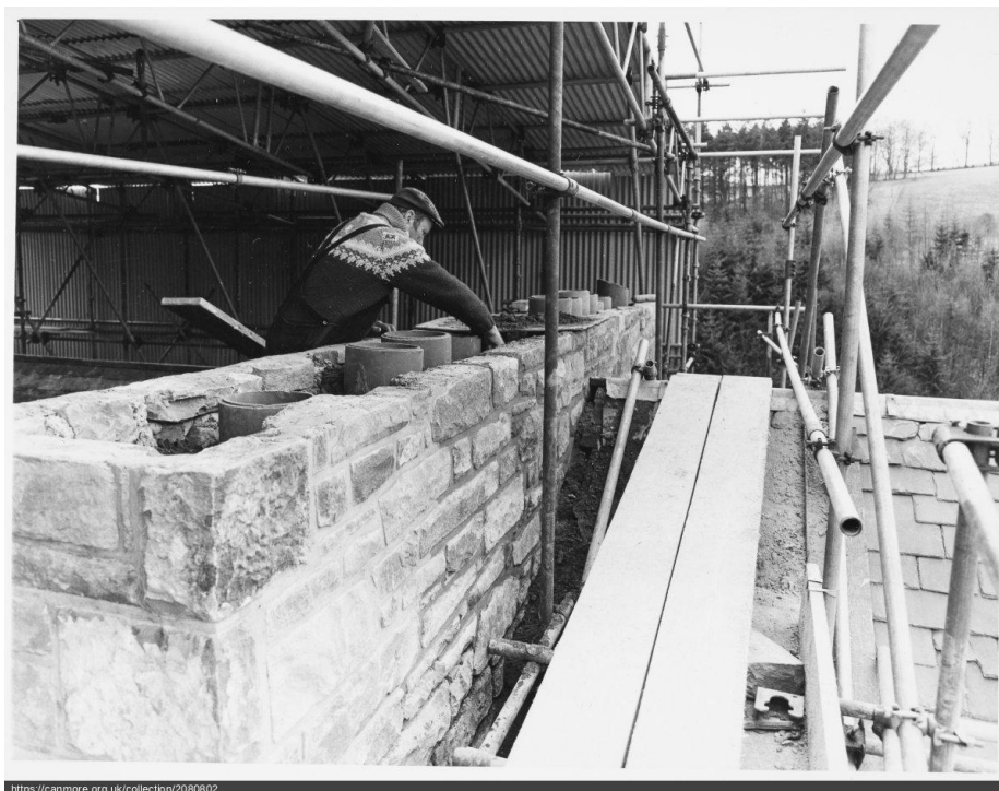
Figura 9. Obras para restauro da chaminé e dos telhadas, realizadas em um dos edifícios habitacionais
