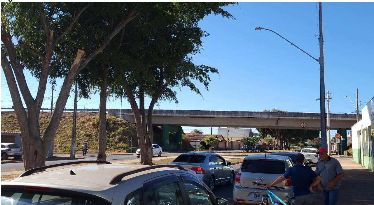
Figura 4. Vista a nível humano do viaduto em Serra do Salitre
