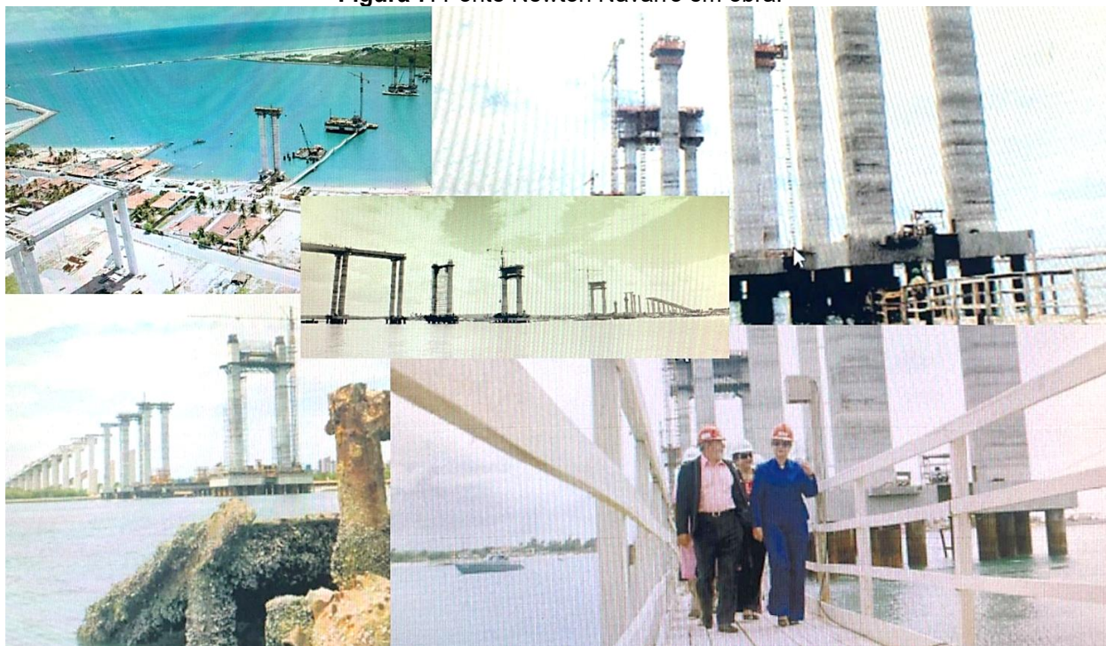
Figura 7. Ponte Newton Navarro em obra.
