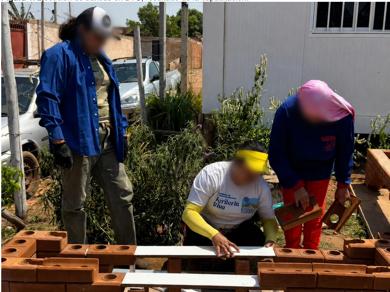
Figura 1. Ejecución de bancas en BTC, resultado de la capacitación.
