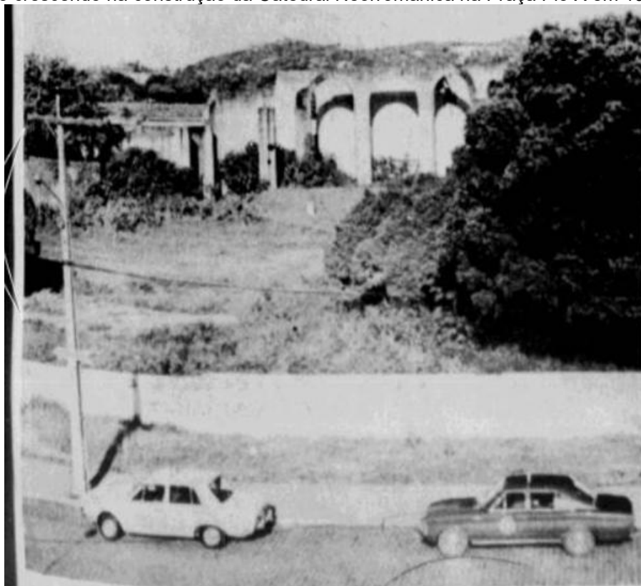
Figura 4. Vegetação crescendo na construção da Catedral Neorromânica na Praça Pio X em 1971.
