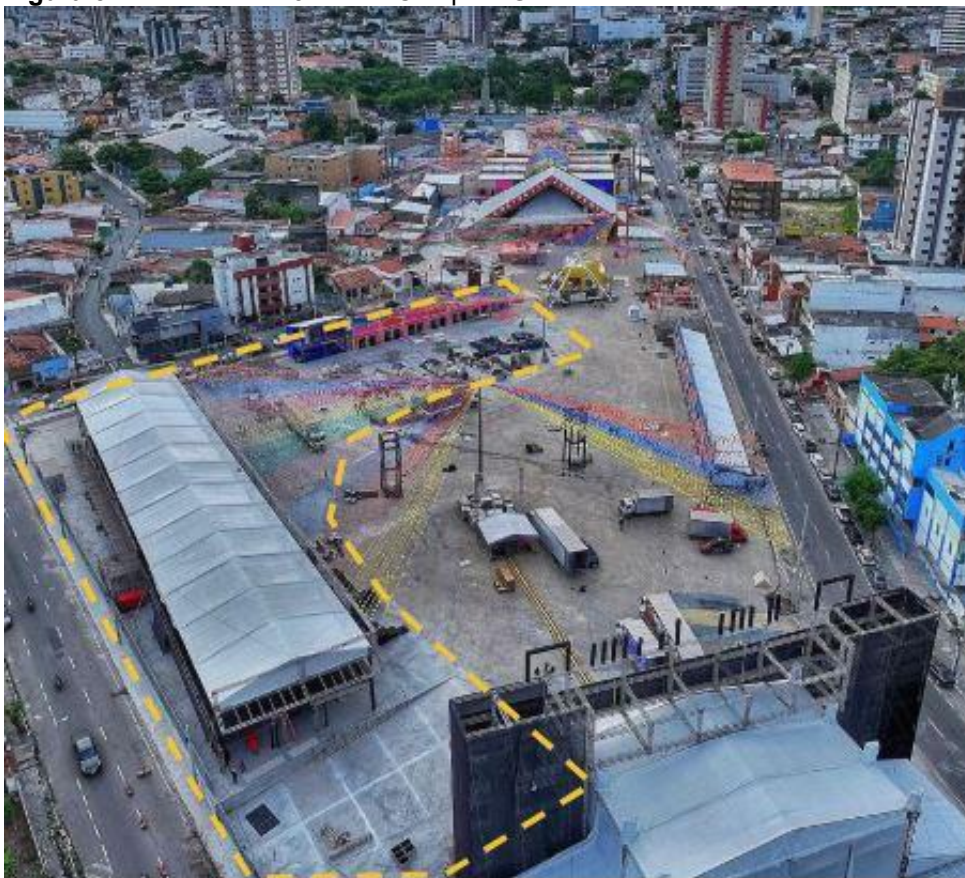
Figura 5. Estrutura São João de Campina Grande
