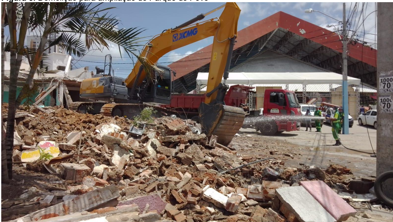
Figura 3. Demolição para ampliação do Parque do Povo
