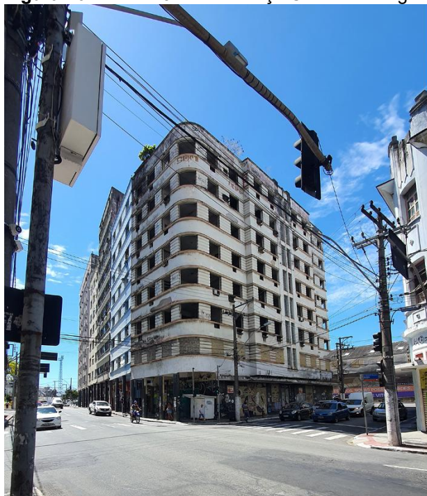
Figura 10. Edifício José Lourenço Costa de Aragão.
