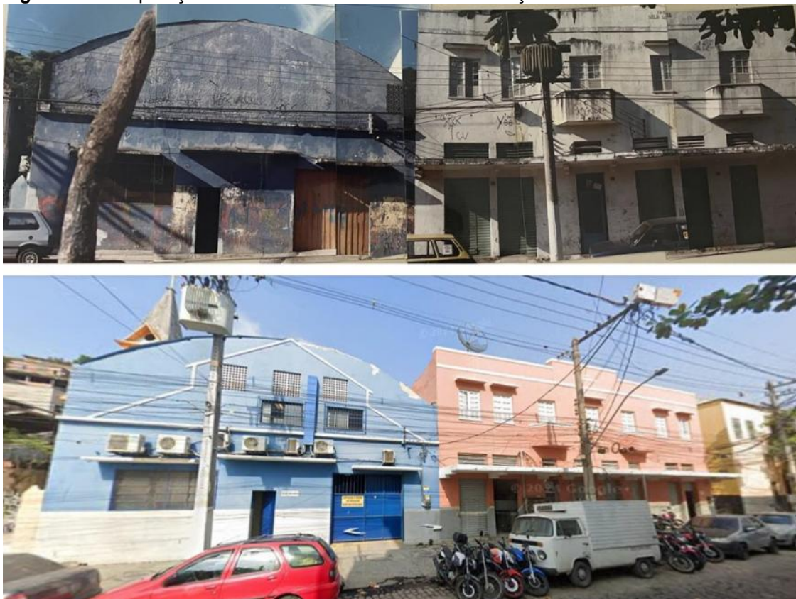
Figura 13: Comparação do mesmo trecho antes da revitalização e atualmente.
