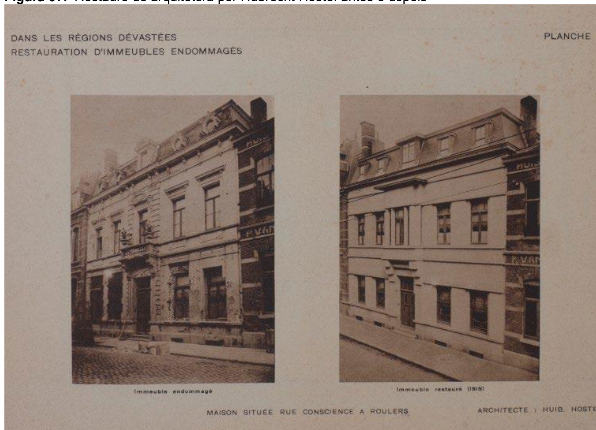
Figura 07. Restauro de arquitetura por Hubrecht Hoste: antes e depois
