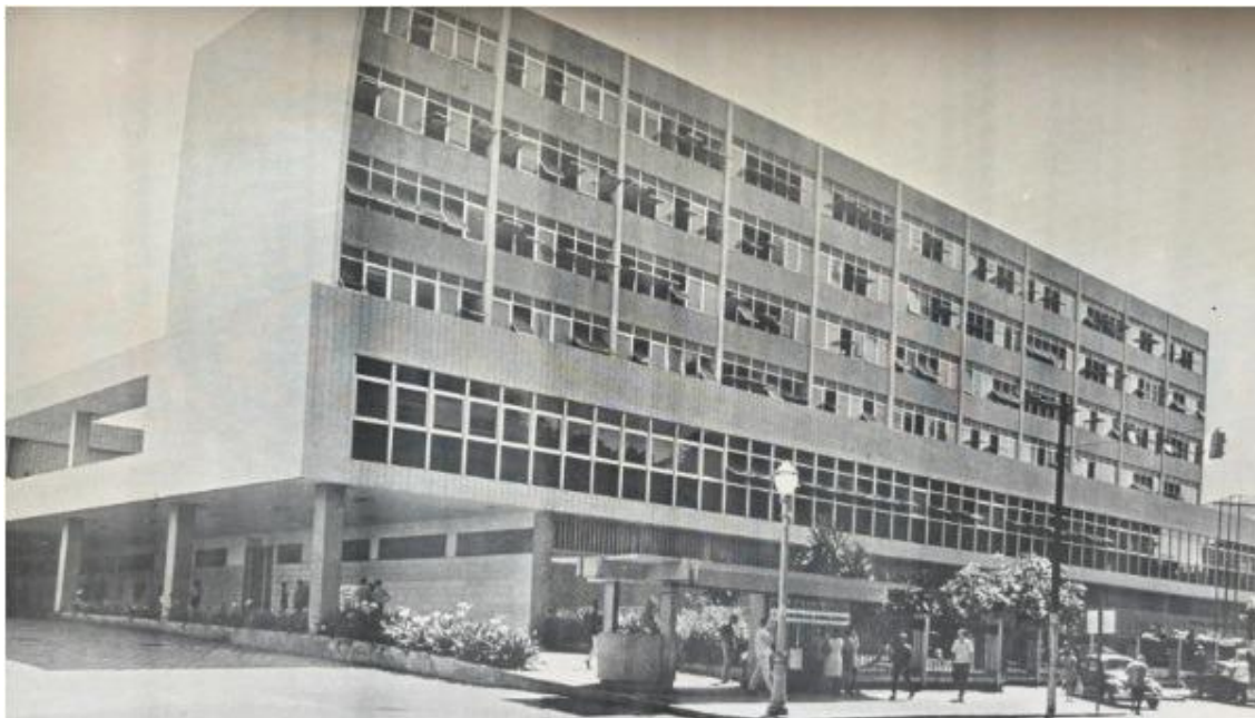
Figura 10 - Atual fachada do Hospital Souza Aguiar
