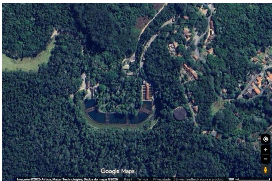
Figura 11. Fotografia aérea da Estação de Tratamento do Alto Cotia.
