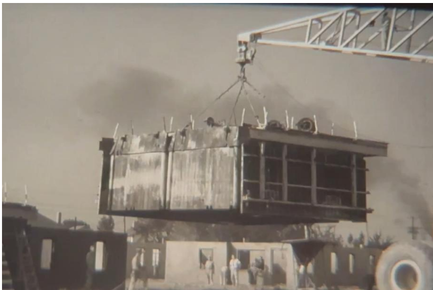
Figura 01: Frame demonstrando a retirada da forma.
