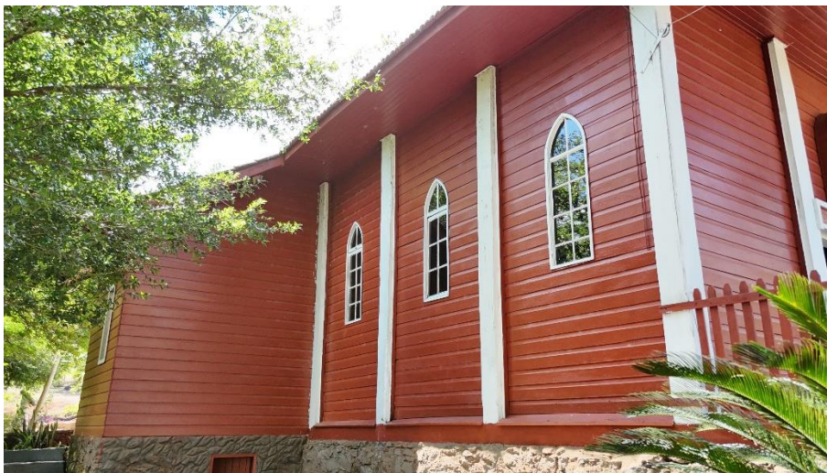
Figura 4. Vista lateral esquerda da edificação
