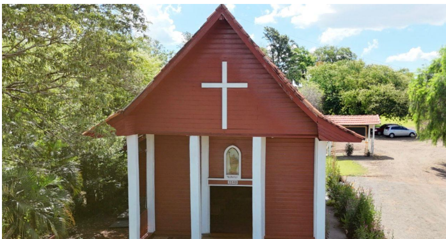
Figura 1. Fachada principal da Capela São Bonifácio
