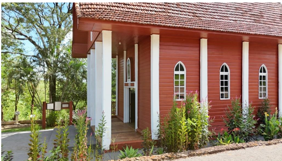
Figura 3. Vista lateral direita da edificação
