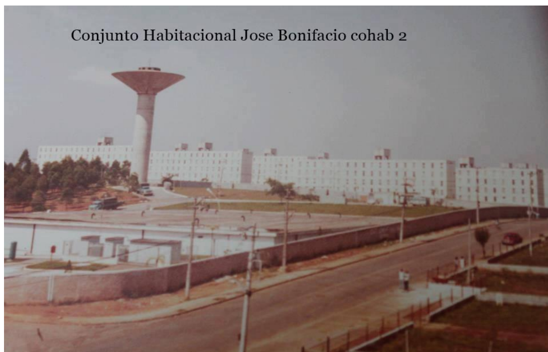
Figura 8. Conjunto Habitacional José Bonifácio (Cohab II) e a caixa d'água, marco visual do bairro
