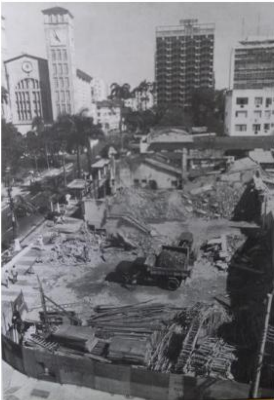
Figura 6. Demolição do Hotel Centro América em 1990
