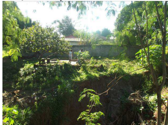
Figura 9: Nascente do Córrego Villa City, voçoroca nas proximidade das residências.
