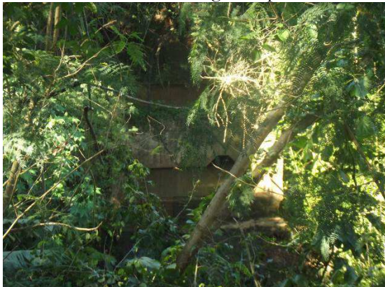
Figura 8: Nascente do Córrego Villa City, canalizado com a galeria pluvial
