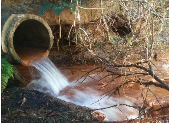
Figura 6: Nascente do Córrego Ouro Branco canalizada e ao lado com a galeria pluvial.
