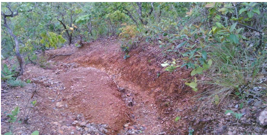
Foto 4 - Processo erosivo em uma das trilhas na Serra de Três Ranchos.
